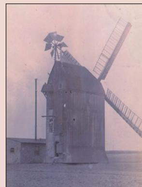
Die Bockwindmühle von Techentin. Die Mühle wurde 1903 gebaut und stand auf einem Feld kurz vor der Karstädter Eisenbahnbrücke. Sie bekam 1920 eine Dampfkesseanlage, die links daneben steht.
